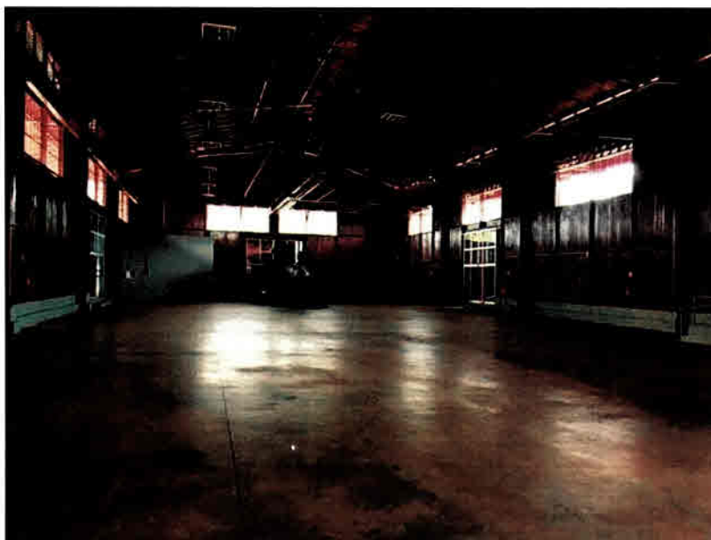
Vista interna – Galpão 01
