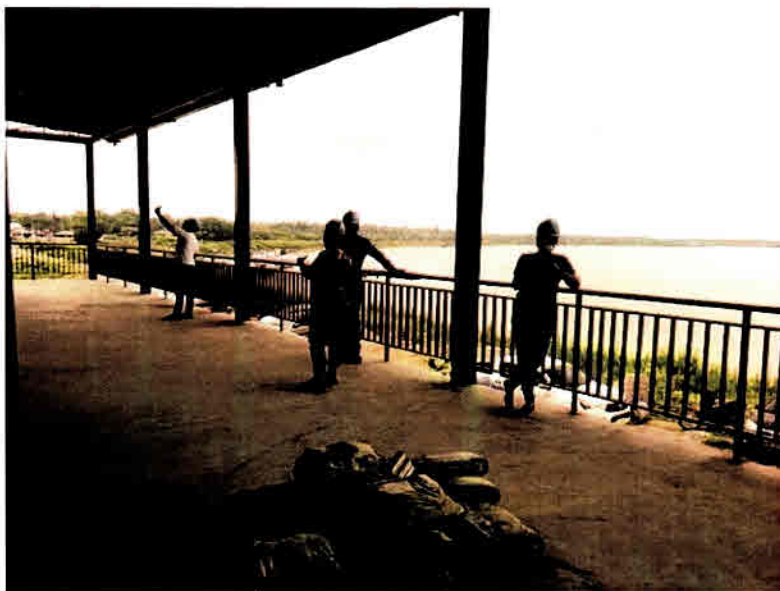
Varanda pavimento superior –Galpão 03
