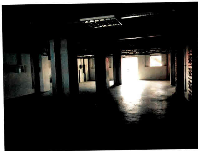
Pavimento Térreo – Galpão 03
