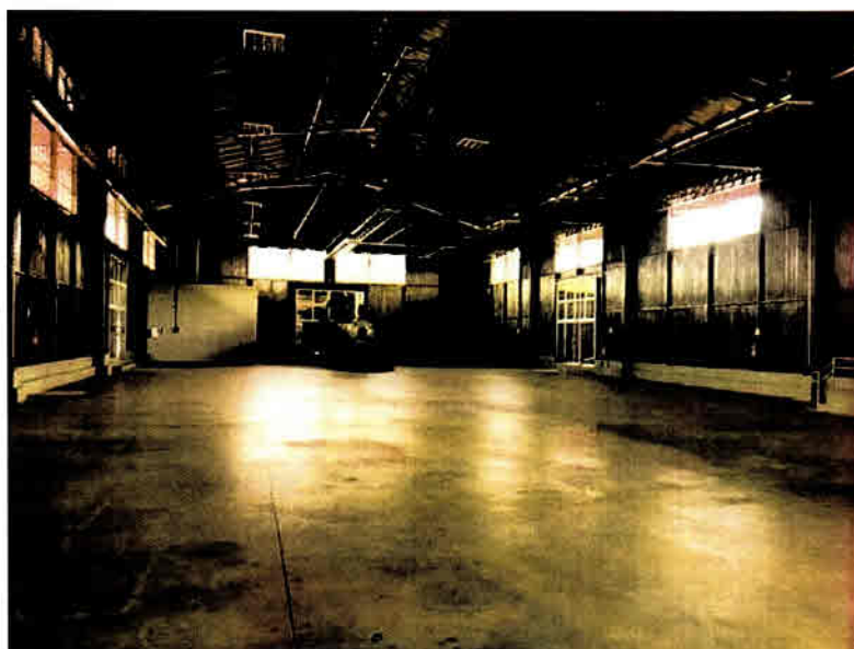
Vista interna – Galpão 01
