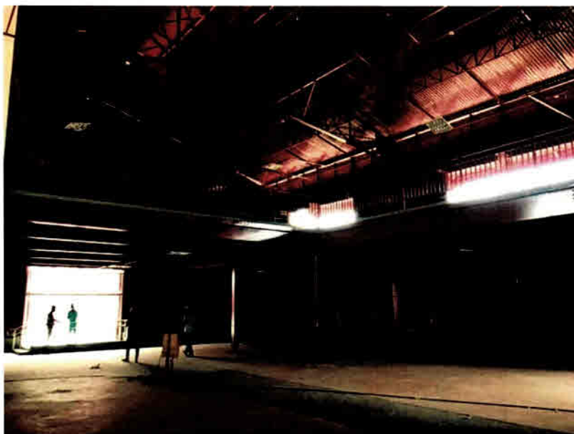
Área interna - Galpão 02
